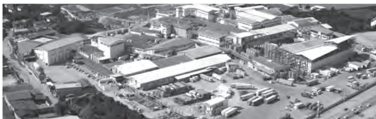
کارخانه کاله، آمل
